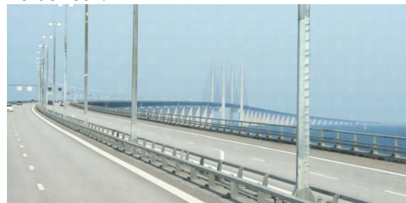
Die fast 16 Kilometer lange Verbindung von Kastrup im Süden Kopenhagens nach Lernacken vor den Toren Malmö besteht aus einem Tunnel, der künstlichen Insel Peberholm sowie einer Hochbrücke
